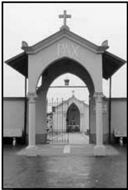
L'ingresso del cimitero ristrutturato
